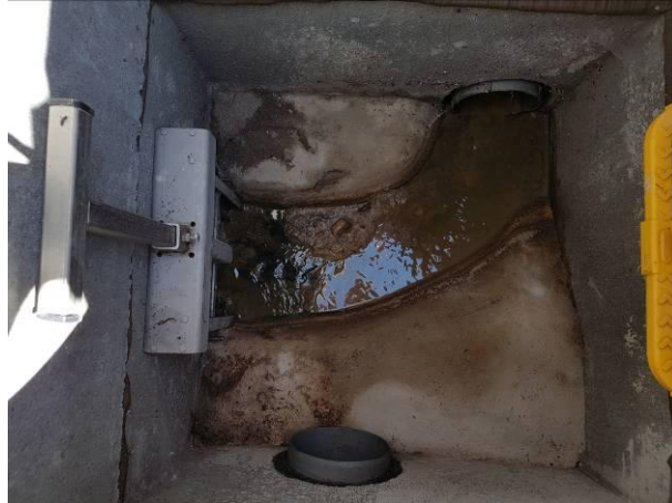
Vue du regard de changement de direction
